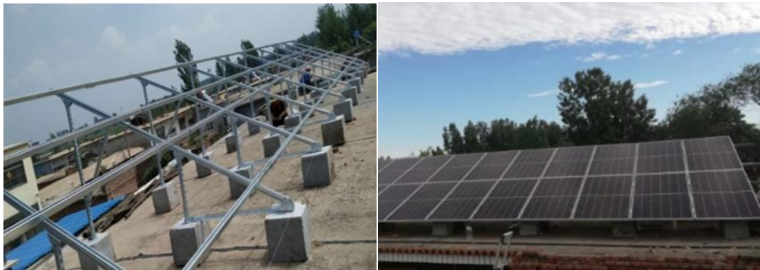
平屋面支架设计（打膨胀）
