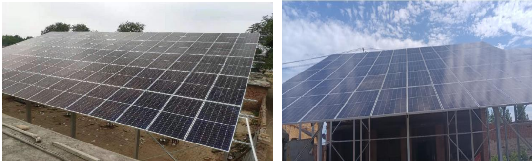
光伏庭院现场照片
