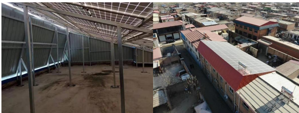
平改坡户用分布式光伏系统照片
