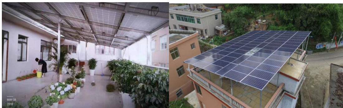
光伏阳光棚现场照片
