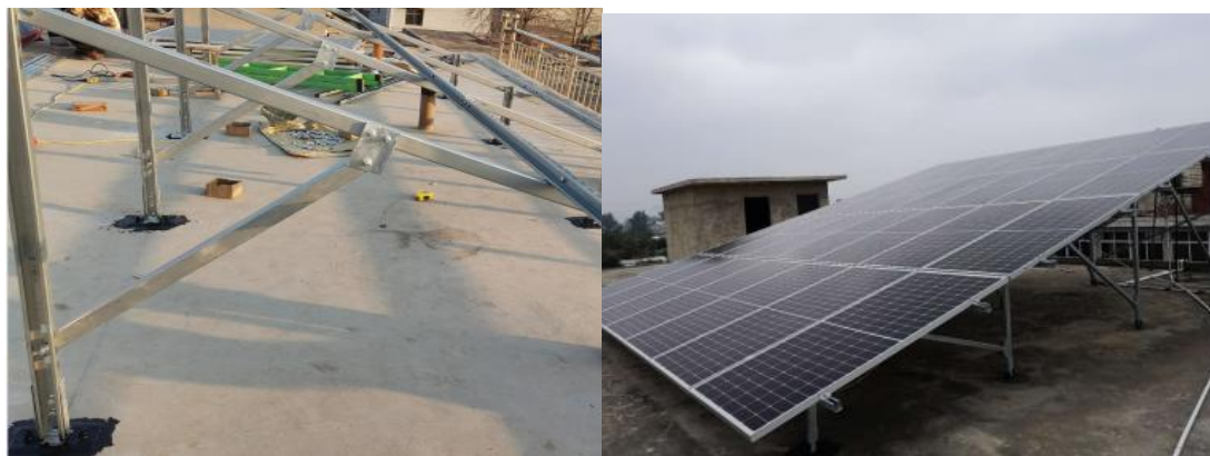
平屋面户用分布式光伏系统照片
