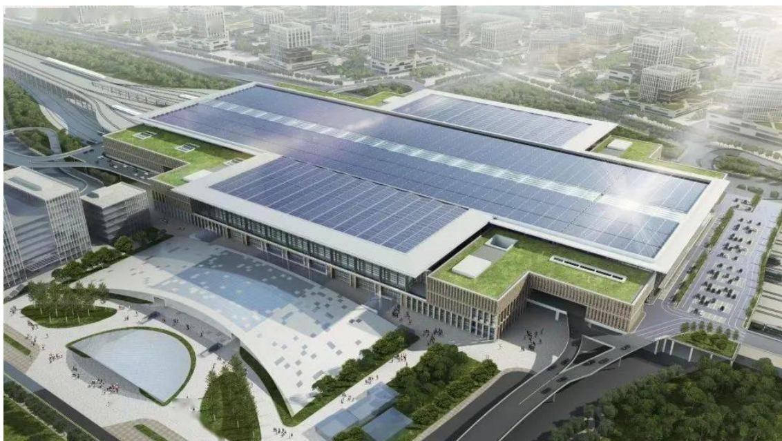
图 1-1 丰台火车站屋顶光伏系统鸟瞰图
